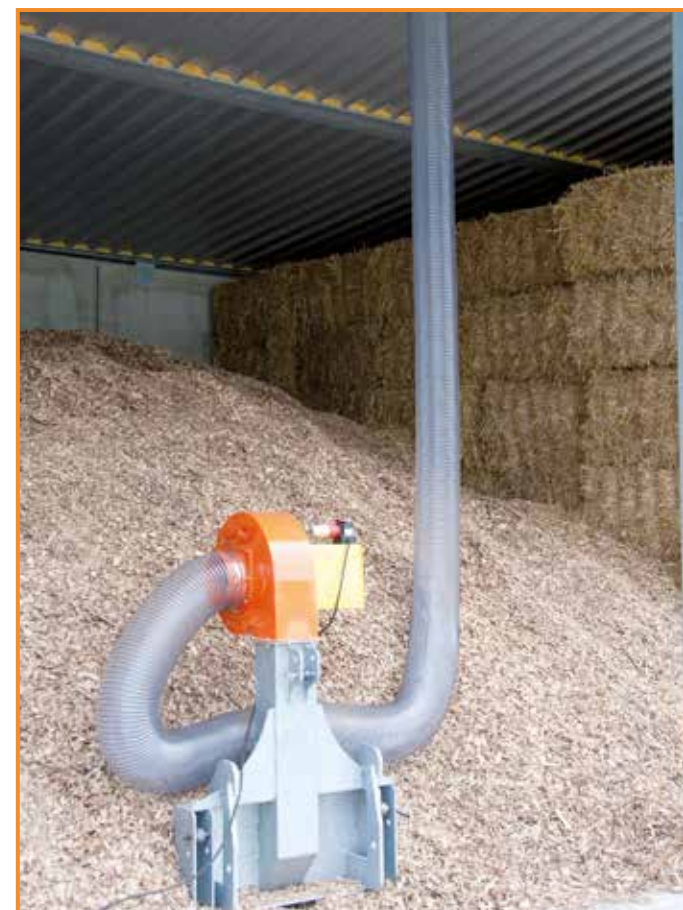
Dachzwischenraum wird abgesaugt
