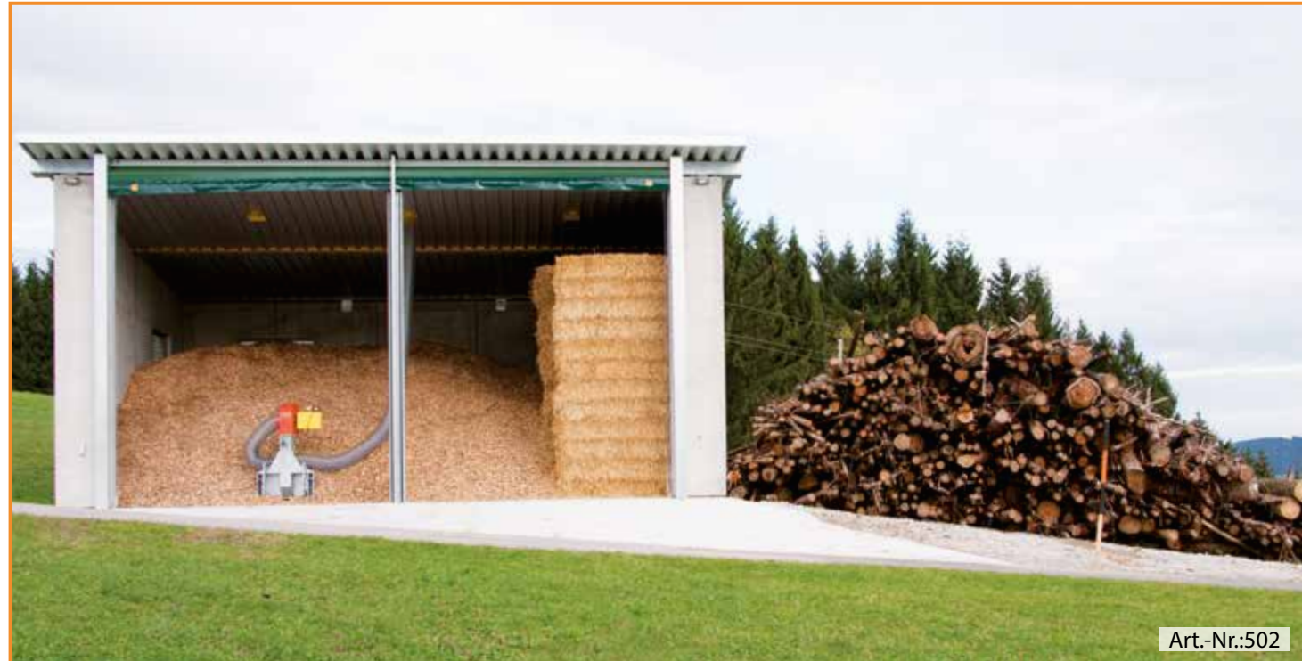
Hackgutlager mit integrierter Dachabsaugung
