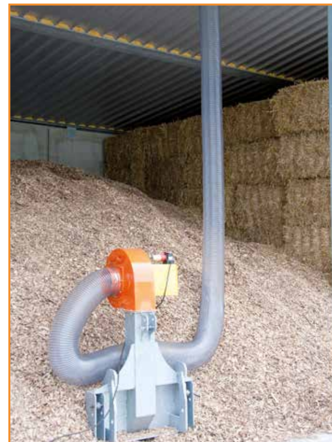
Dachzwischenraum wird abgesaugt
